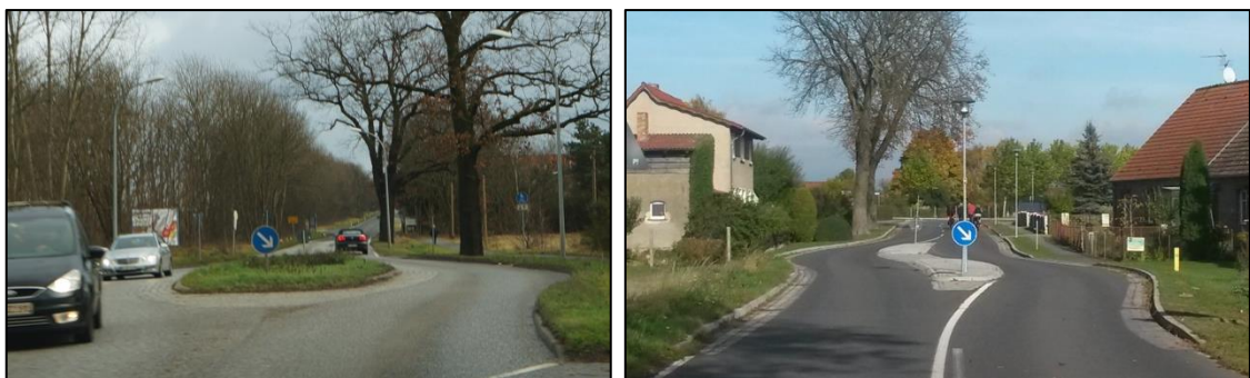
Abb. 24 Beispiele Ortseingangsgestaltung mit Fahrstreifenversatz
